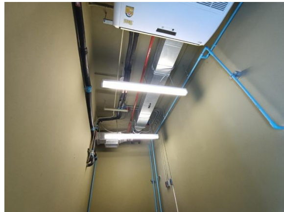
รูปที่ 2-52 จัดให้มีพัดลมดูดอากาศ ภายในห้องพักขยะ
