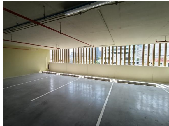
รูปที่ 2-21 ช่องว่างเปิดโล่งเพื่อการระบายอากาศชั้นลานจอด
