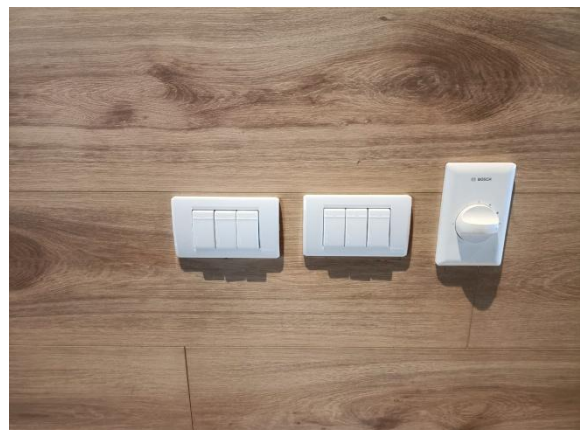
รูปที่ 2-28 สวิตช์แยกเพื่อเปิด-ปิดไฟในจุดที่ไม่มีการใช้งาน
